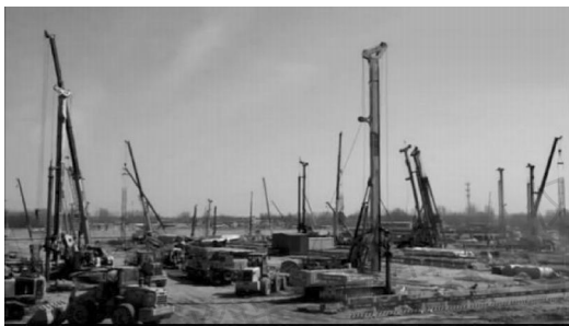
图 3-1 京雄城际铁路雄安站施工现场中的液压工程机械
