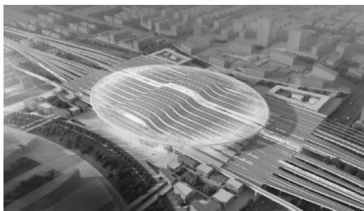
图 3-2 雄安站站房外观
